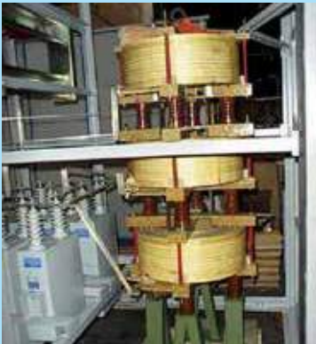
Inductancias (choke) para filtros o líneas montaje interior serie 1,2 kV
